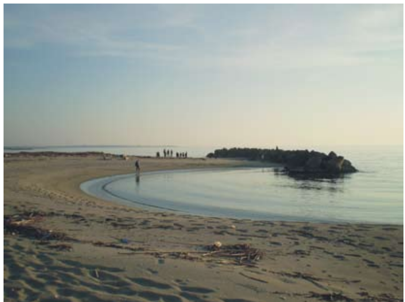
«Τόμπολο»: Χαρακτηριστικό παράδειγμα αποτυχημένης διαστασιολόγησης έργου παράκτιας προστασίας
