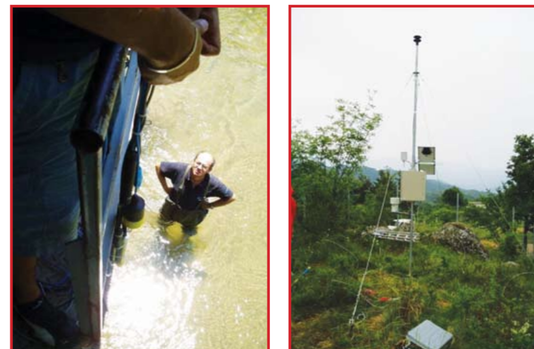
Εικόνα 3. Φωτογραφίες από την εγκατάσταση των τηλεμετρικών σταθμών στην Γαλάνη (αριστερά) και στο Καρούφουτο (δεξιά).
